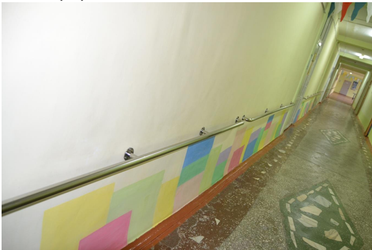
Фото № 7 Коридор 2 этаж.
