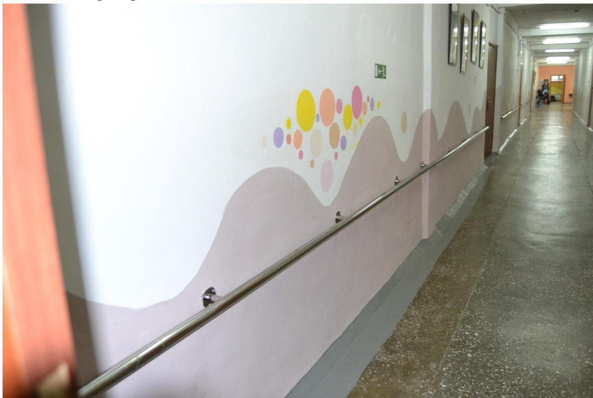
Фото № 6. Коридор 1 этаж.
